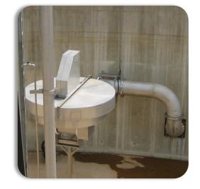
debajo de la superficie del agua. El drenaje sólo se realiza tras el ciclo de sedimentación, cuando el mano de fangos se encuentra asentado en el fondo del tanque.
